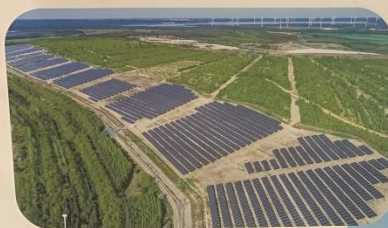
PV Deponie Jänschwalde I
