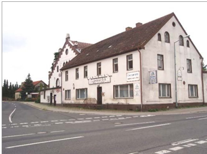
Ansicht vor dem Abriss der ehemaligen Gaststätte
