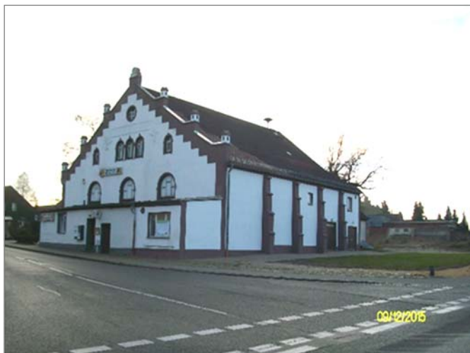
Ansicht nach dem Abriss der ehemaligen Gaststätte
