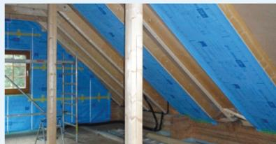
Minderung des Wärmeenergieverbrauches über Dachgeschossdämmung
