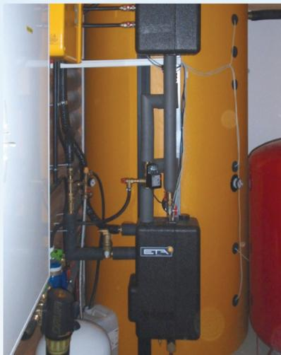
Wärmeenergieversorgung aus erneuerbaren Energien mittels Pufferspeicher
