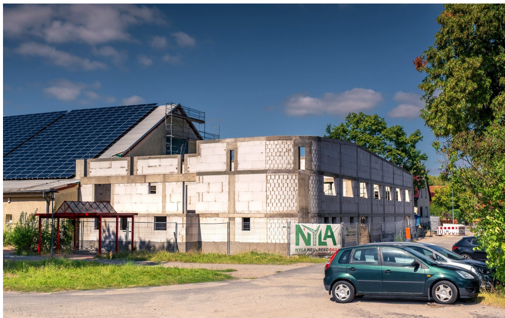
Erweiterung Mehrzweck-Sporthalle Rietschen
