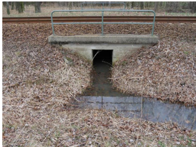
Abbildung 10 Durchlass unter der Bahnlinie
