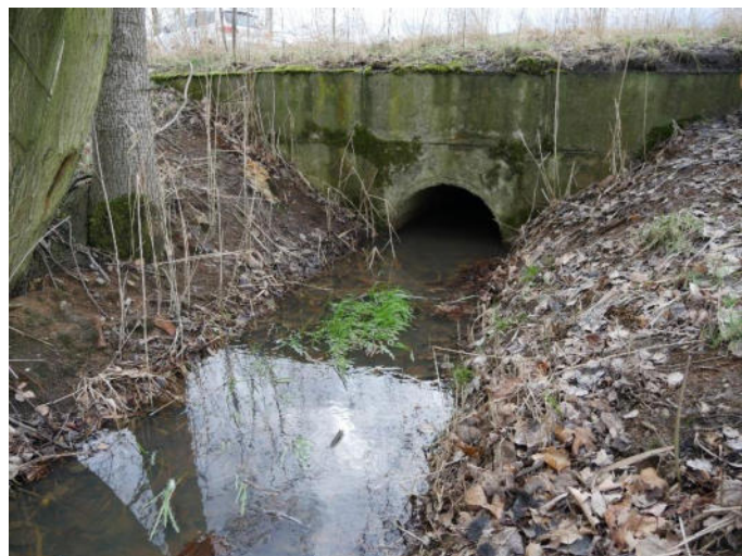
Abbildung 11 Durchlass unter dem Radweg
