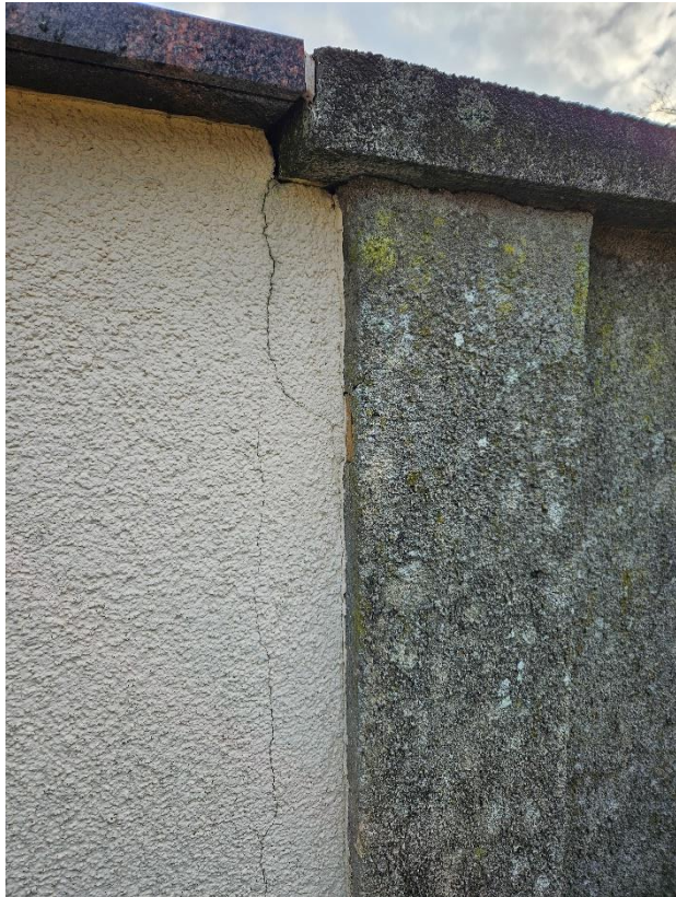
Innenansicht Mauer, Bereich mit Namenstafeln von Verstorbenen der Urngemeinschaftsanlage - Risse
