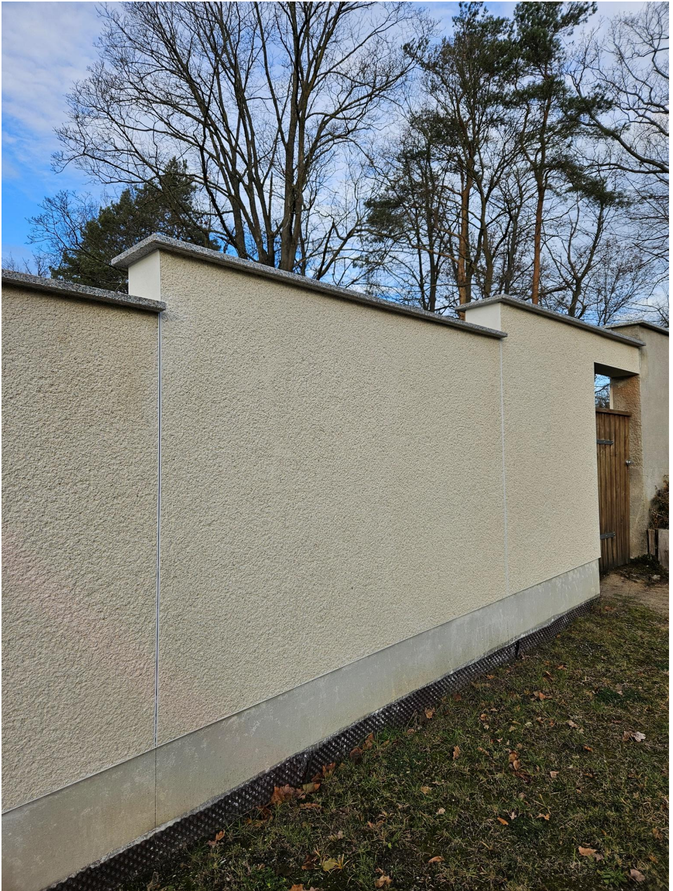
Teil neu sanierte Mauer Außenseite (mit Abdeckung aus Granit und Dehnungsfugen)
