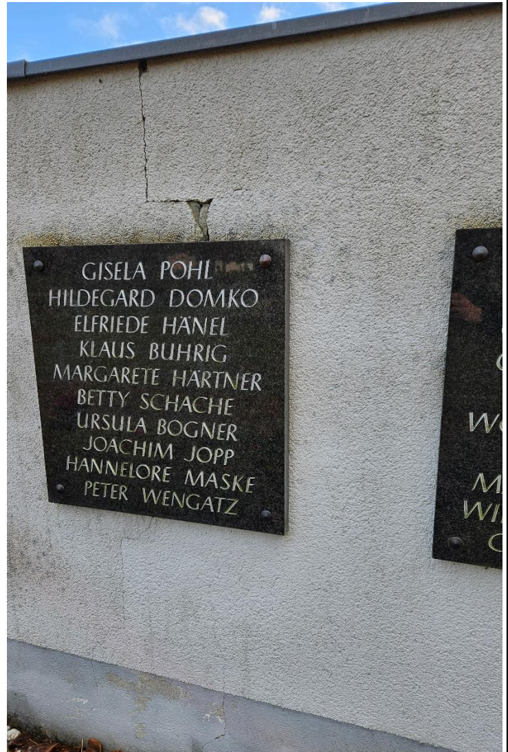
Innenansicht Mauer, Bereich mit Namenstafeln von Verstorbenen der Urnengemeinschaftsanlage - Risse
