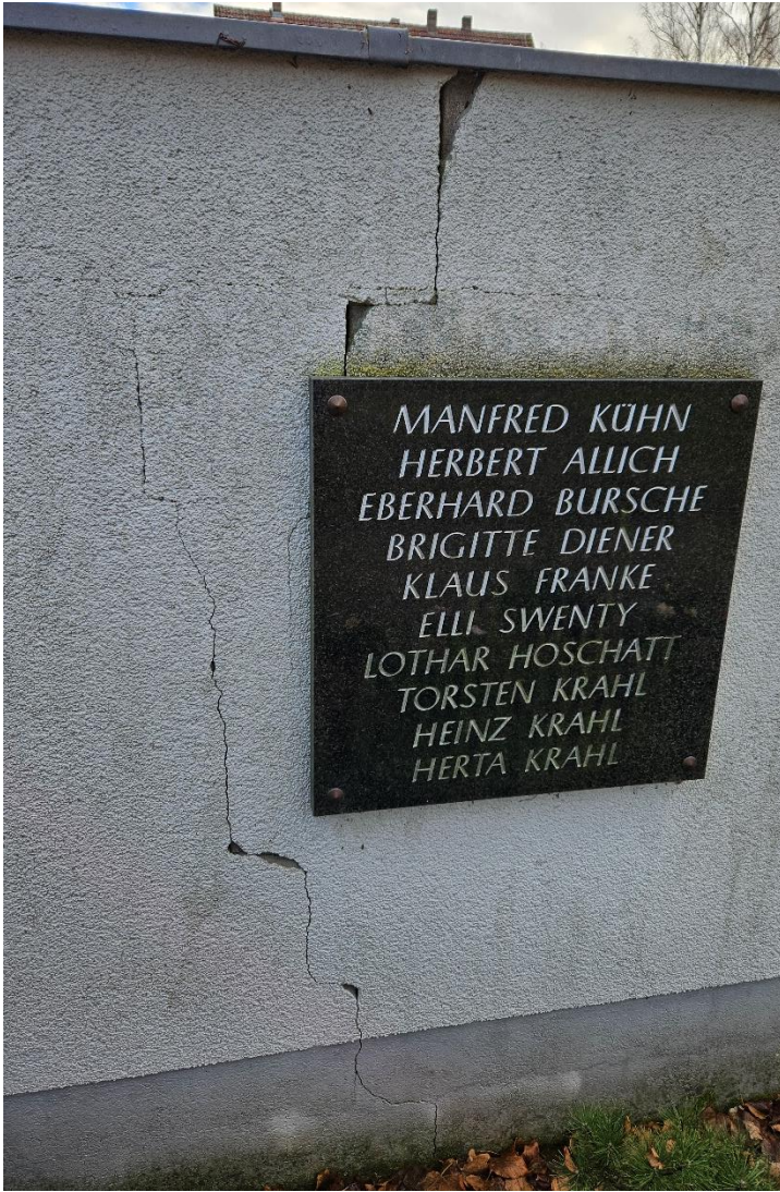
Innenansicht Mauer, Bereich mit Namenstafeln von Verstorbenen der Urnengemeinschaftsanlage - Risse
