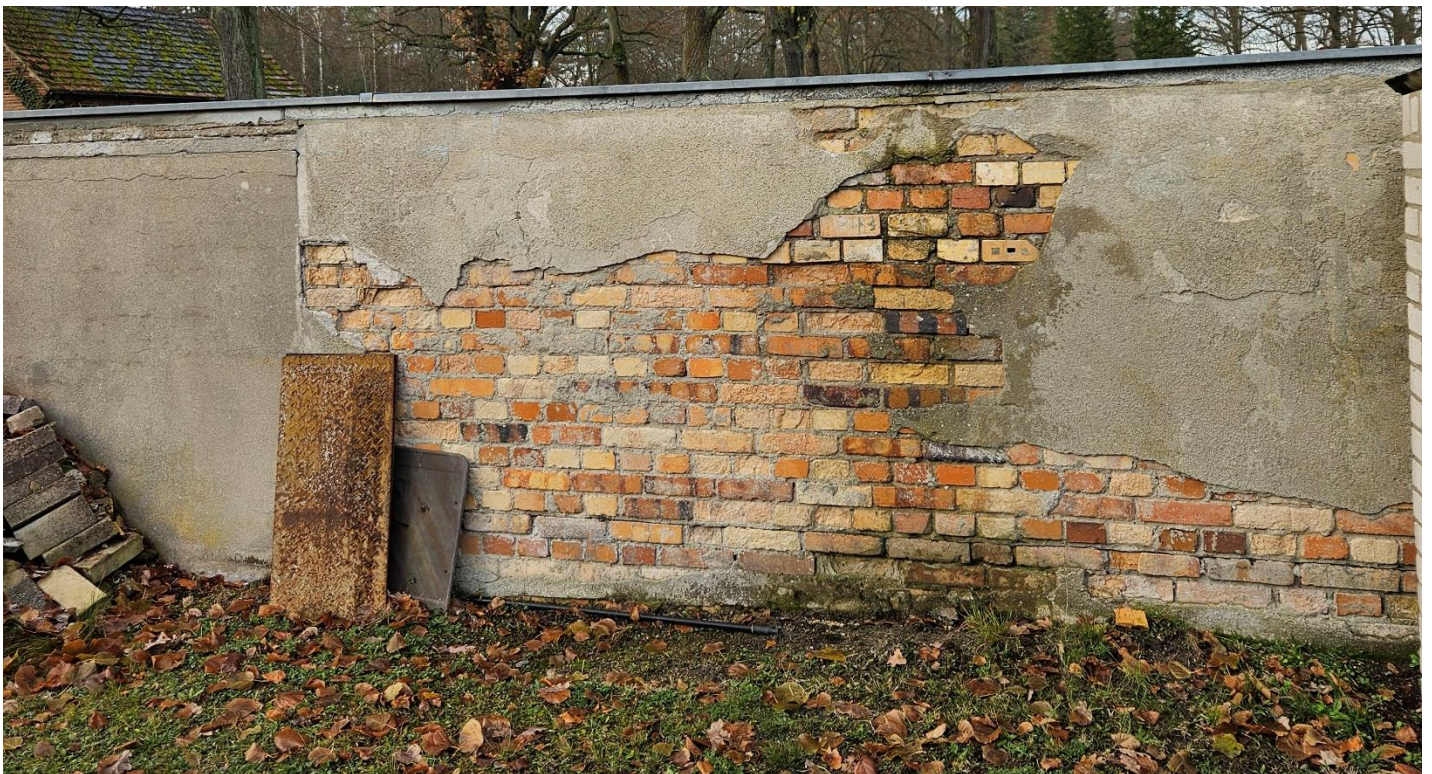
Außenansicht Mauer mit Schadstellen
