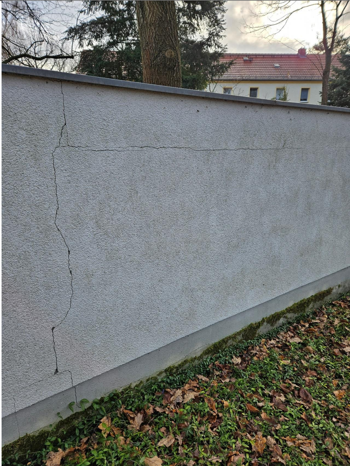
Innenansicht Mauer, Bereich mit Namenstafeln von Verstorbenen der Urnengemeinschaftsanlage (Mauer dicker als im Bereich der Mauergrabstellen) - Risse
